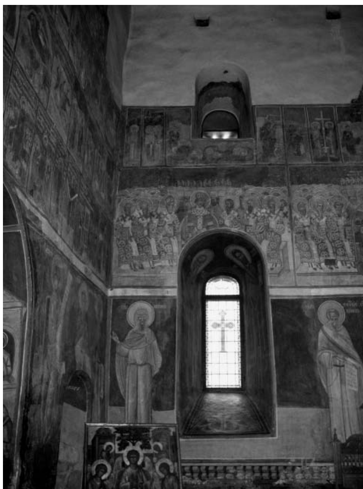
Fig. 3 – Cozia. Eglise du monastère. Narthex. Rosace initiale et fenêtre ultérieurement aménagée.
