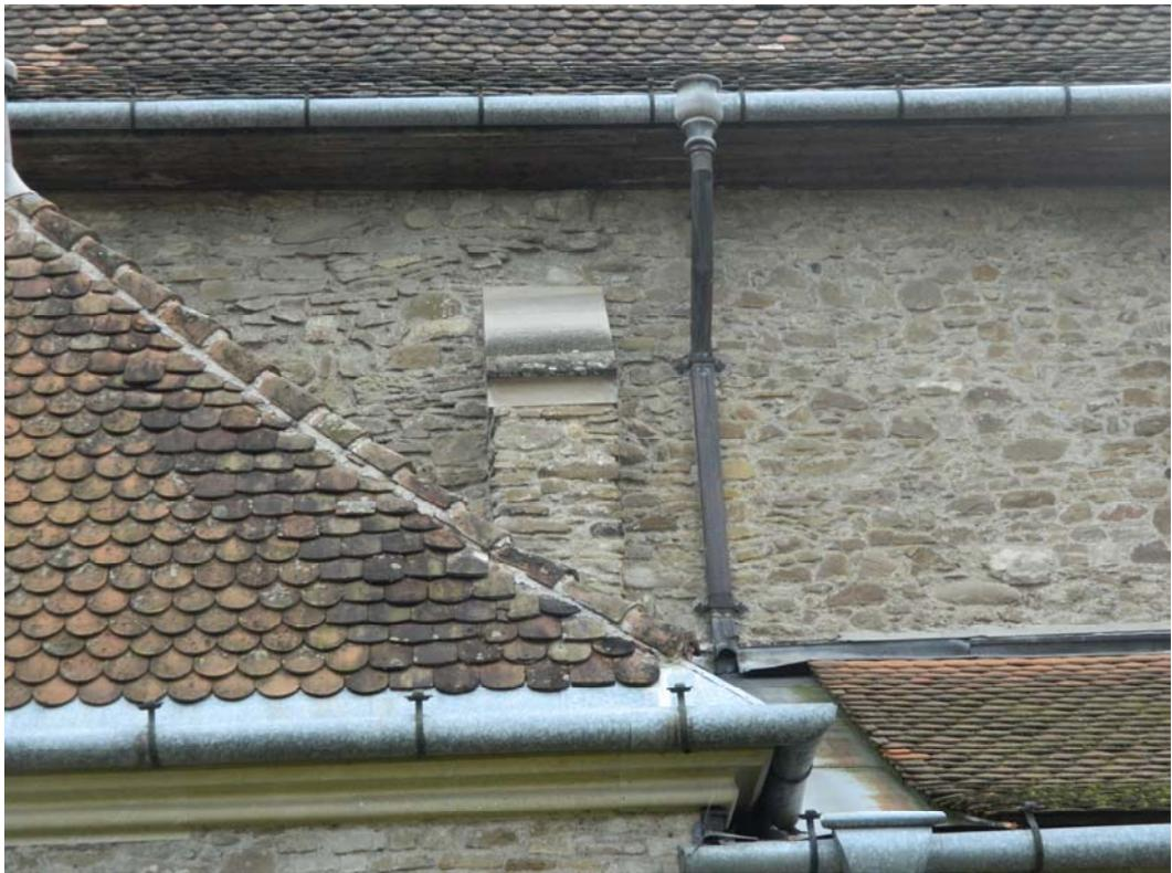
Fig. 16 – Le mur nord du chœur, tassement différent des assises cachées par le premier contrefort.
