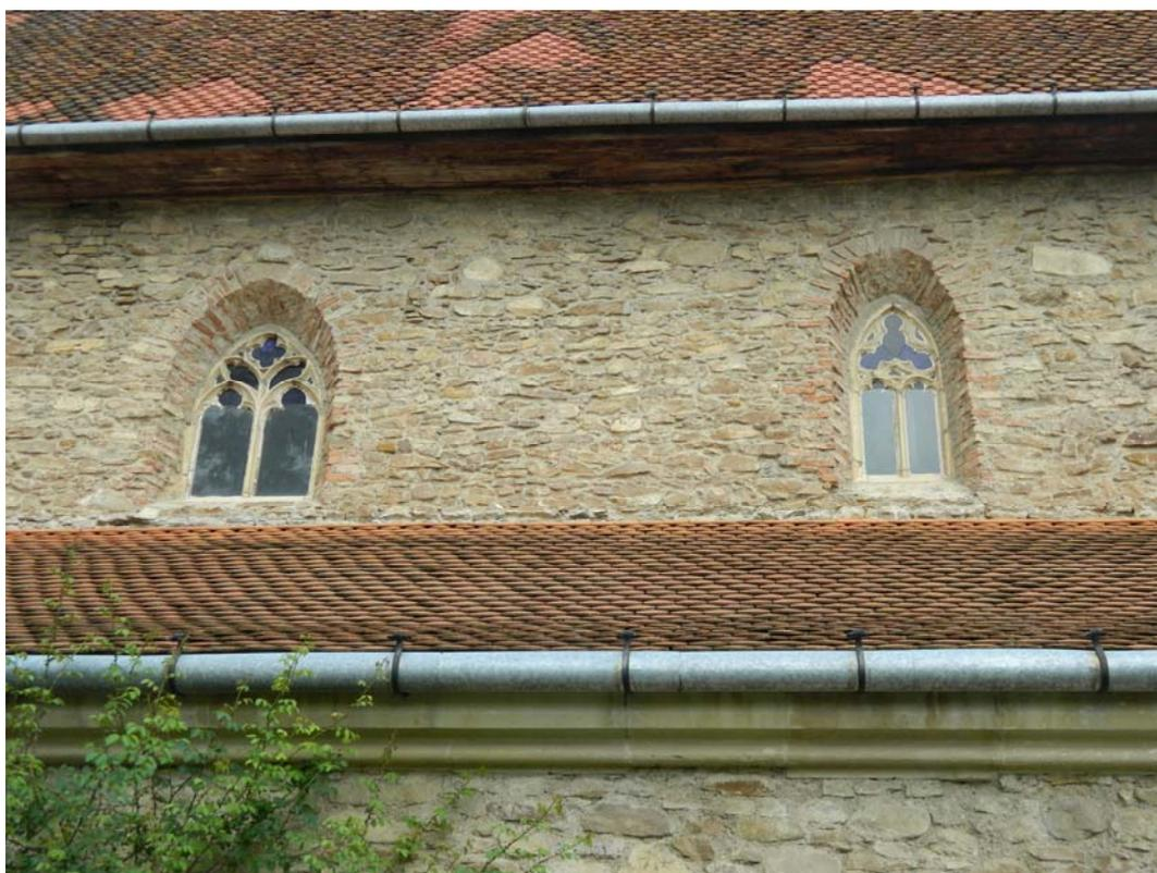
Fig. 17 – Le mur nord de l'église, l'inadvertance entre la forme de l'ouverture arrondie des fenêtres et les encadrements en arc brisé.
