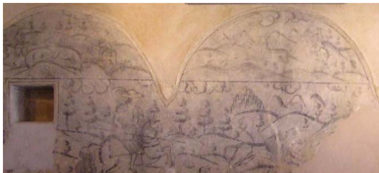
3.16. Sighișoara, casă pe strada Școlii nr. 4-6 Foto : Romeo Gheorghiuță
