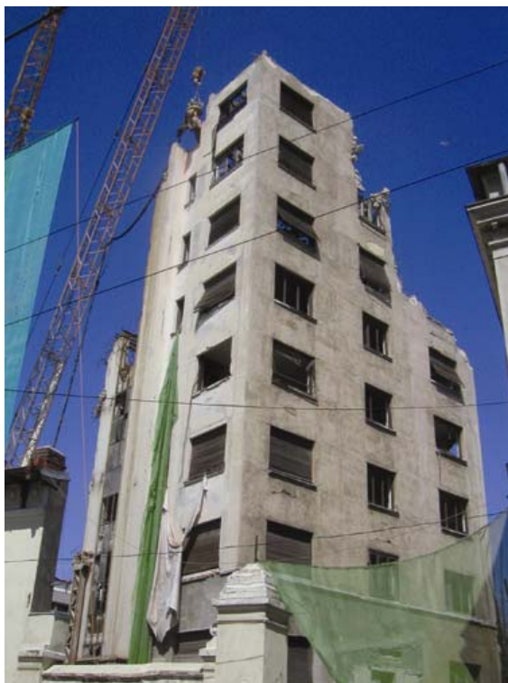
Fig. 7 b. Ministerul Industriei constructoare de mașini în timpul demolărilor văzut de pe Str. Gen. Manu (aprilie 2007).
