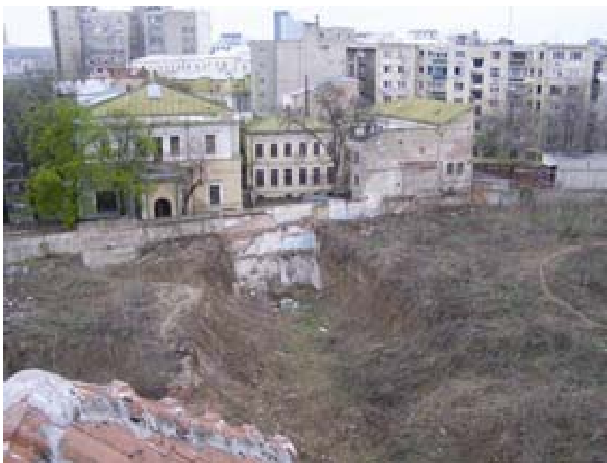
Fig. 5 e. Grădina Palatului Știrbei desfundată de demolări – spațiu destinat ridicării a două turnuri de circa 30 etaje, foto ASI.
