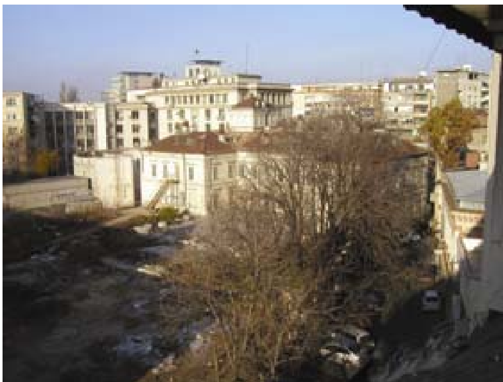
Fig. 5 b. Palatul Știrbei, fațada dinspre grădină înaintea demolărilor (decembrie 2007) văzut din Str. Banului, foto ASI.
