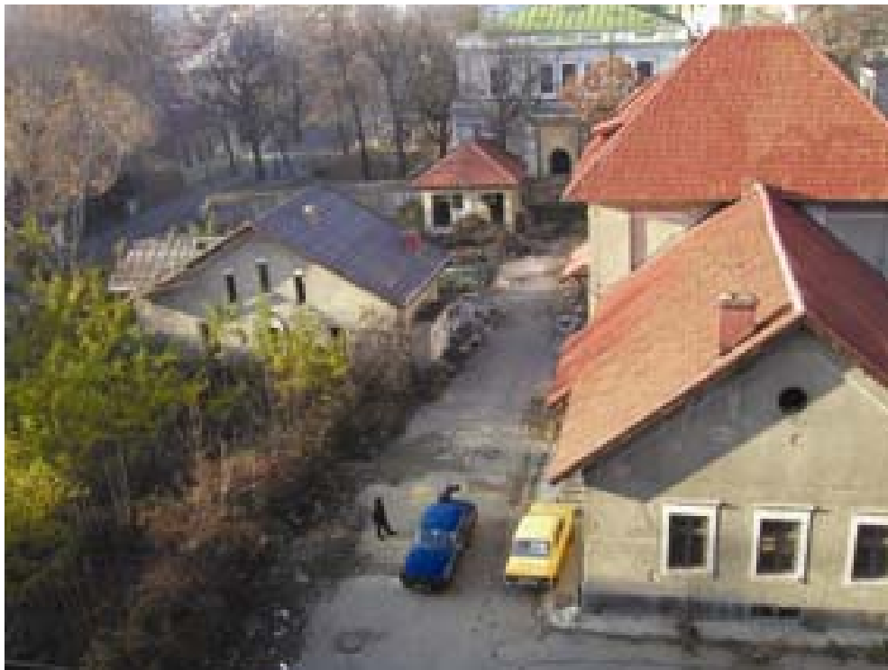
Fig. 5 d. Clădirea Intreprinderii Zarea cu atenansele ei înainte de demolare (decembrie 2007) văzută din Str. Banului, foto ASI.
