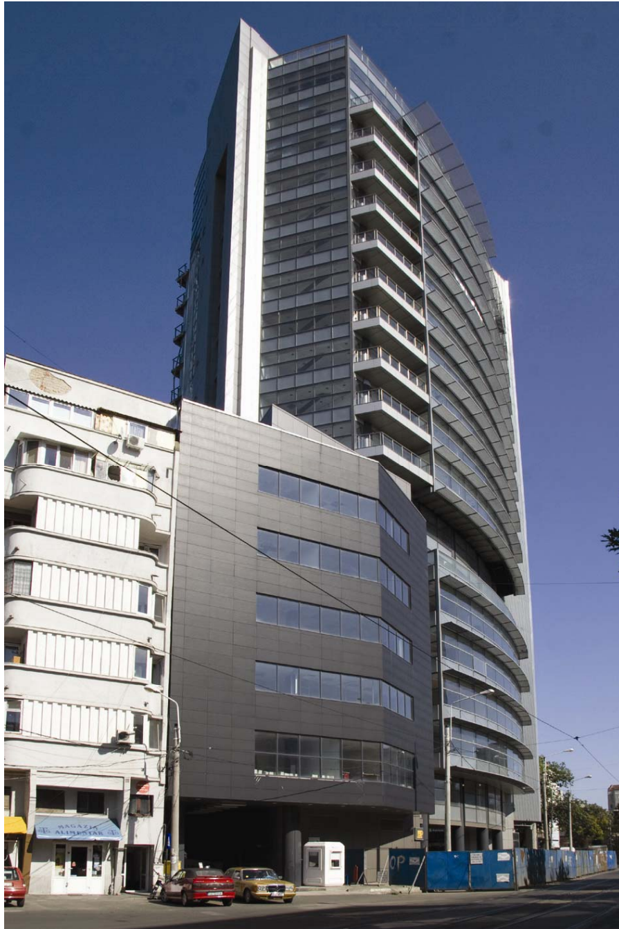
Fig. 2 c. Millenium Estate văzut de pe strada Armand Calinescu, foto S.Chițu.
